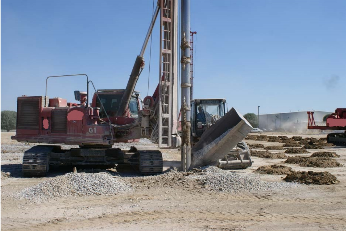
Figure 5-9. Top feed vibro rig.
